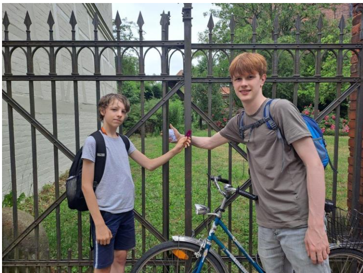
Foto: Zusammengeschobene Eingangspforte in der Görgestraße
